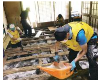
平成30年7月豪雨災害での ボランティア活動の様子(宍粟市)
